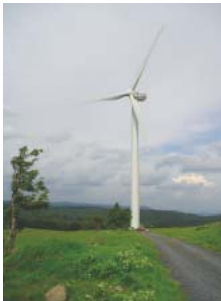
Větrná elektrárna u Nové Vsi v Horách. Zpevněné komunikace pro servis a obsluhu jednotlivých větrných zařízení umožní snadný přístup nežádoucích návštěvníků do míst, kam by se jinak nedostali Foto Ondřej Volf
