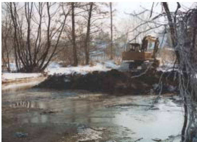
Průběh odbahňování Ramene u Stříbrného potoka v prosinci 2001, použití pásové techniky
