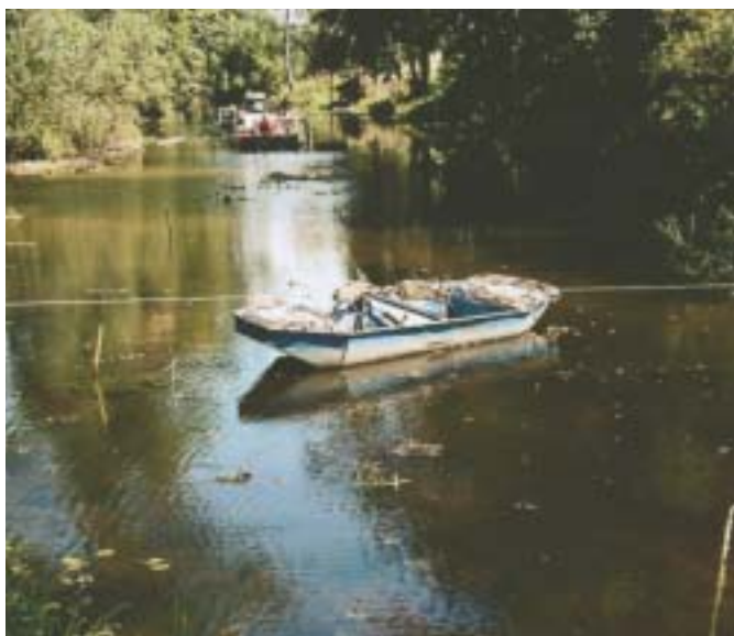
Používaná technika – sací bagr – odbahňování dolní části slepého ramene v srpnu 2003: ukotvení bagru pomocí lan, dřevěnými kolíky označeny populace rdestů, které nebyly vyjmuty z vody a přechovávány v náhradním prostředí
