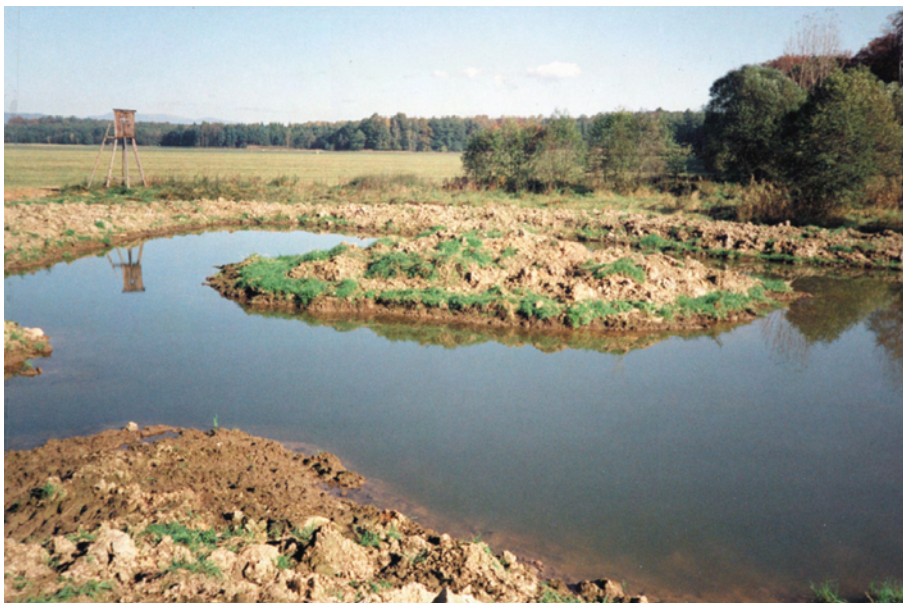
Nově vybudované tůň pro rozmnožování obojživelníků v PP Za mlýnem v CHKO Litovelské Pomoraví, stav těsně po realizaci r. 1995
